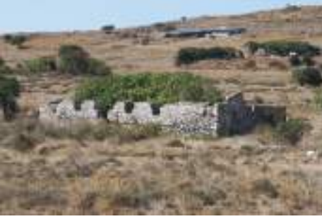
Res.11: Küçük kilise, genel görünüş.
