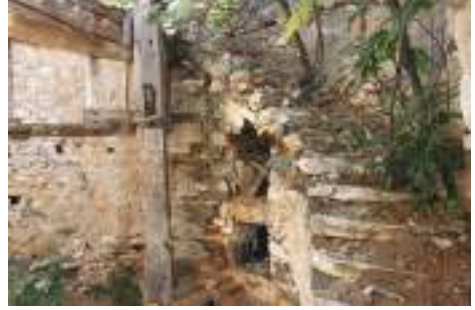
Res. 27: Değirmen, taş merdiven.
