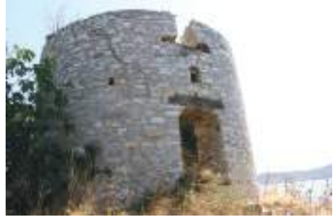
Res. 25: Değirmen, genel görünüş.
